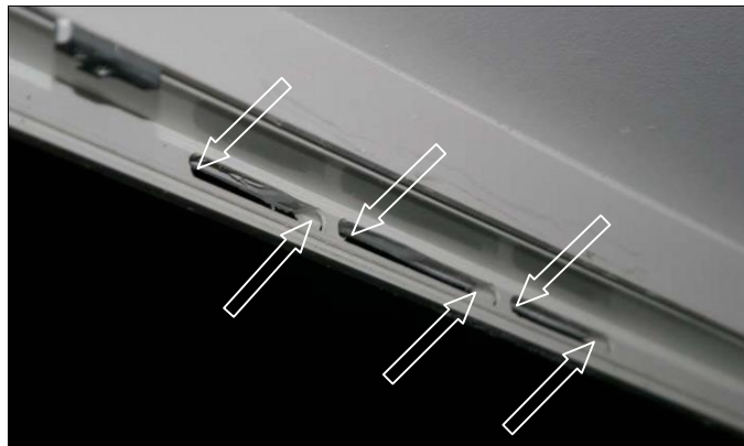
Примеры выполнения технологических отверстий на окнах:
